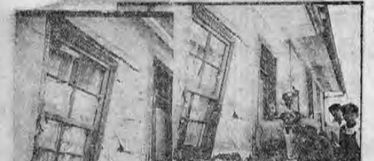
Muestra el grabado, a la derecha, el aspecto en que quedó la pared de una casa de habitación después de la acometida de un automóvil izquierdo: curiosos presenciando los desperfectos.
